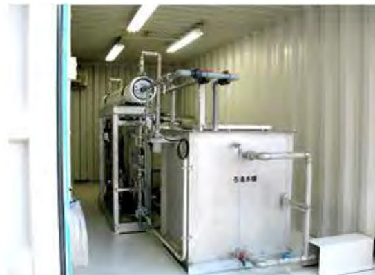
壇の洗浄用水として使用する井戸水に基準値を超えるフッ素が検出されたため、当社の水処理装置を採用していただきました。
