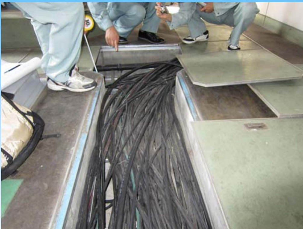
＜従来形＞多数の制御線による配線
