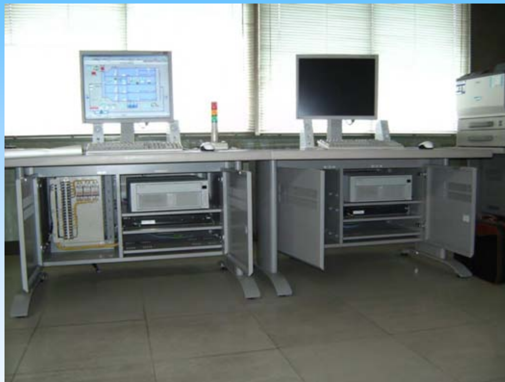
＜現在形＞ FAパソコン+LCD監視設備
