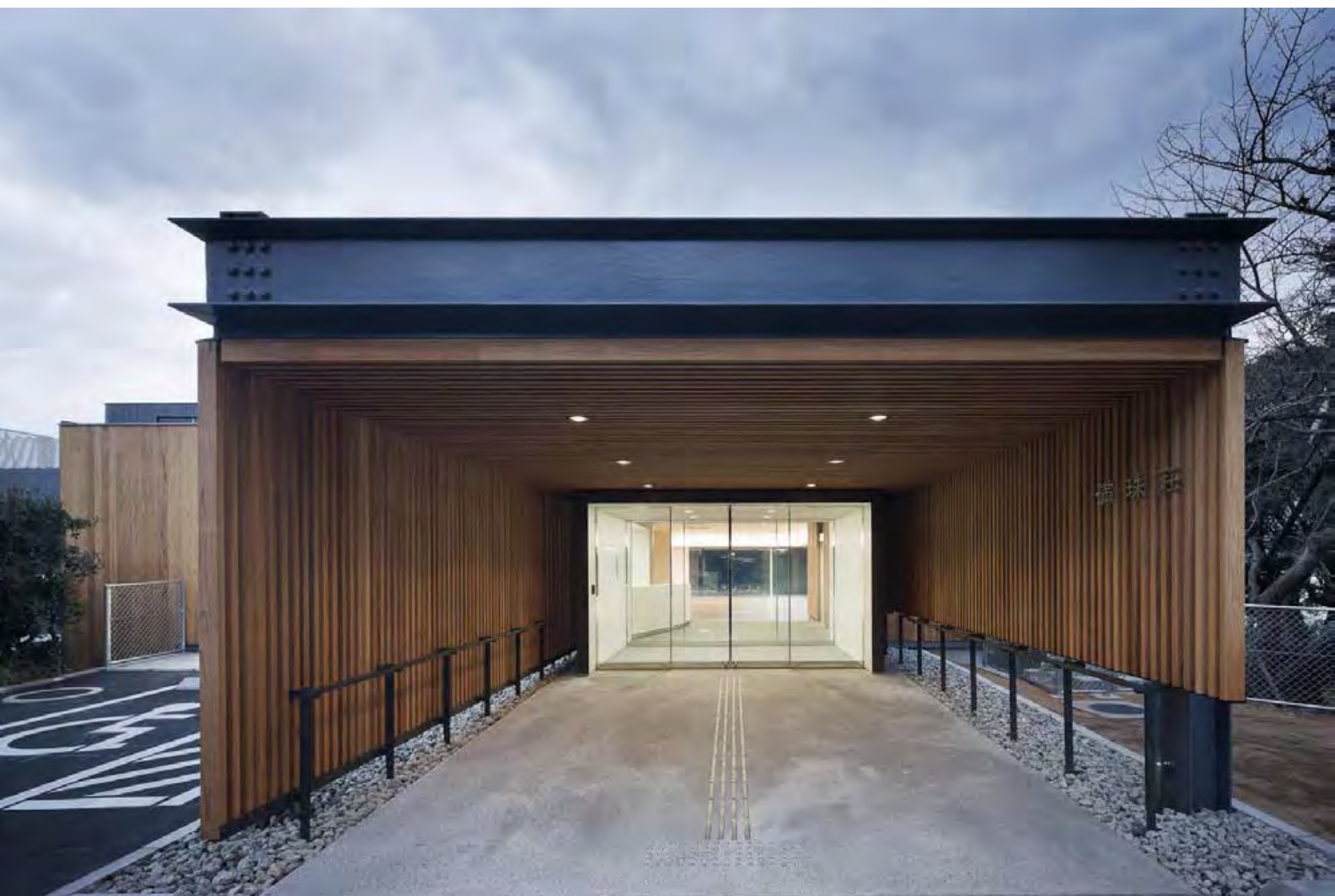
リファイニング後エントランス
