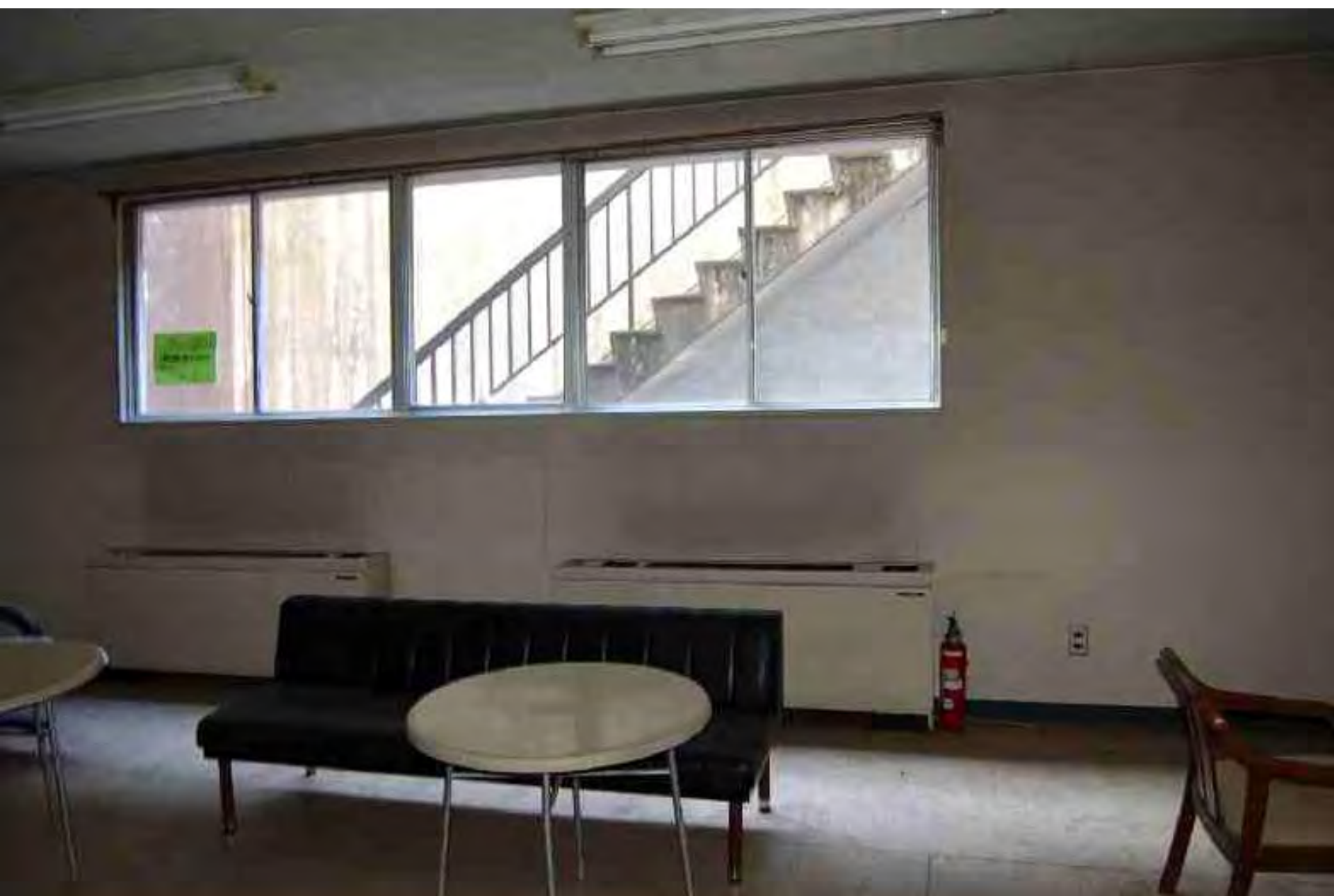
既存地下ロビー
