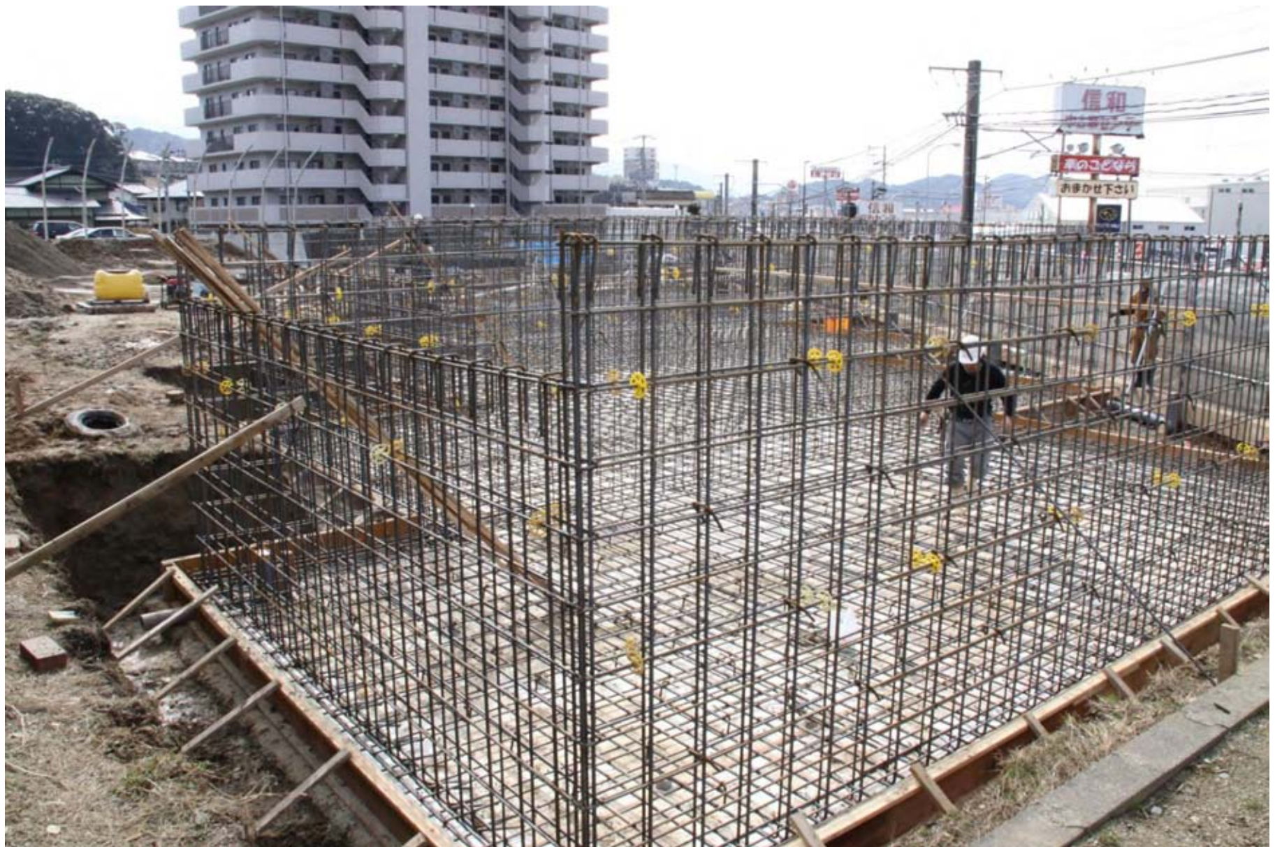
地下工作物の鉄筋組立ての様子
