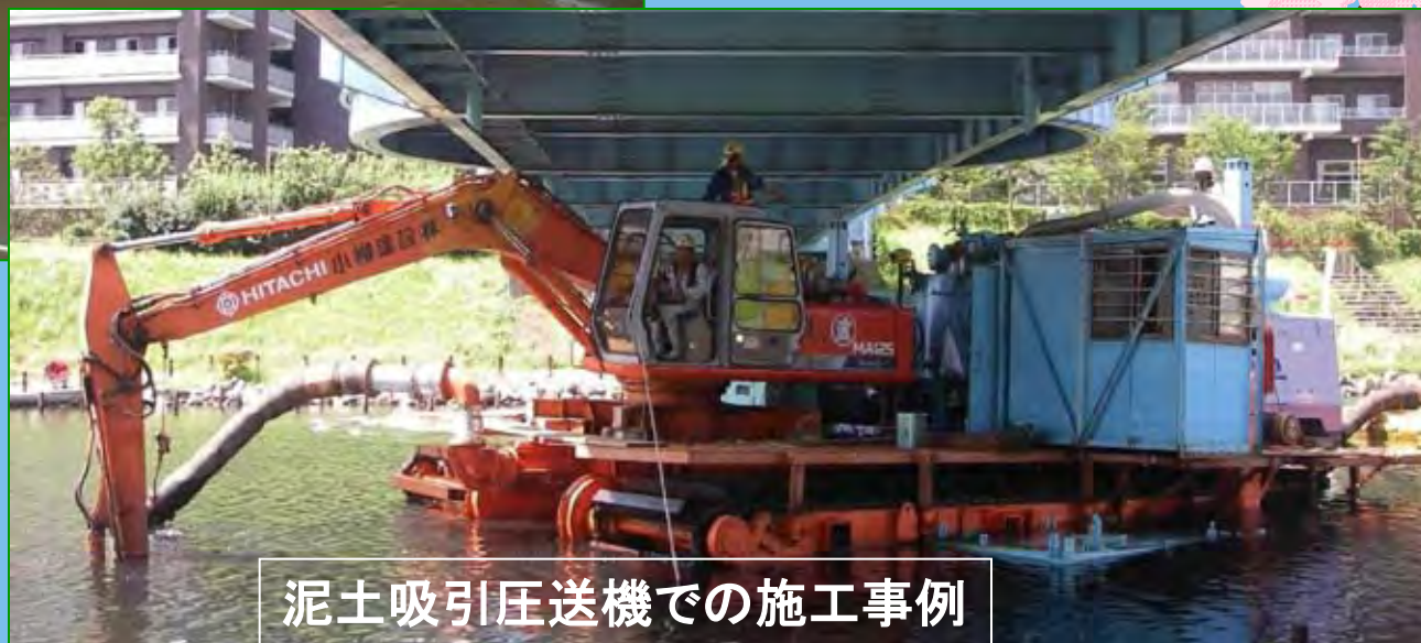
泥土吸引圧送船での施工事例
