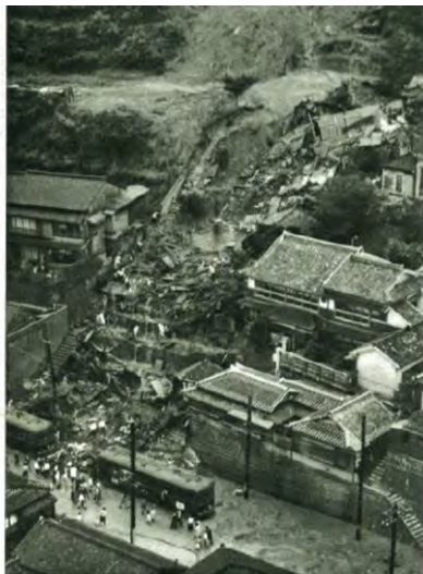
延命寺の土崩れにより、延命寺住宅地帯と一帯に押しがすがぬき勢いで物置の破壊を見た。(延命寺附近の惨状) (朝日新聞提供)
