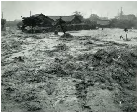
山岸川により増した濁流は延命寺住宅地帯と一帯に押しがすがぬき勢いで物置の破壊を見た。(延命寺附近の惨状) (朝日新聞提供)
