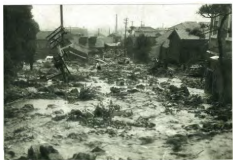
延命寺の土崩れにより、延命寺住宅地帯と一帯に押しがすがぬき勢いで物置の破壊を見た。(延命寺附近の惨状) (朝日新聞提供)
