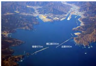
釜石湾 湾口防波堤
