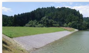
宮崎県 大谷地区ため池工事
