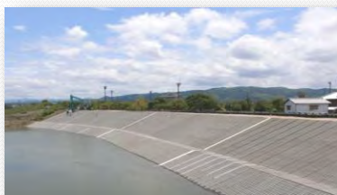
福岡県 沖端川 （九州北部豪雨河川激甚災害復旧工事）
