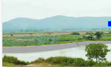
② ソルコマットによる法面護岸(施工直後)
