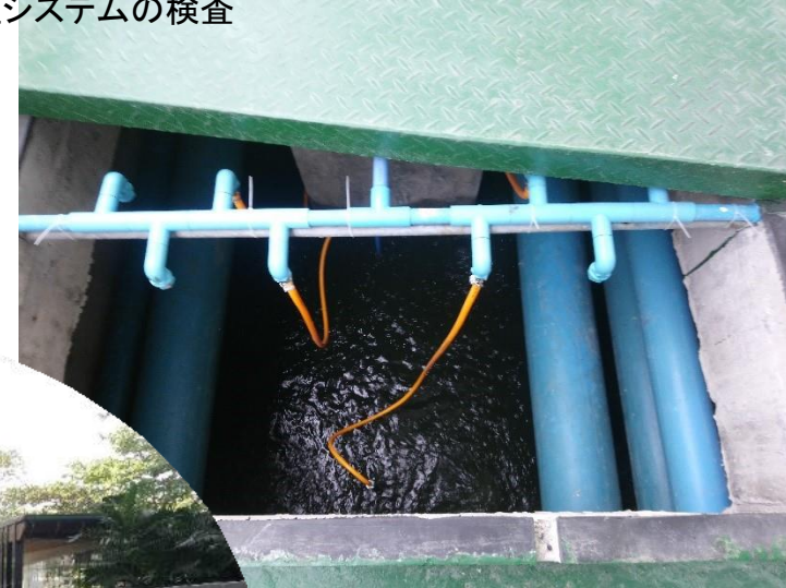
浄化槽を使った分散型下水処理システムの検査
